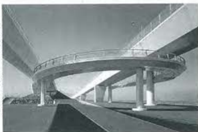
境界が変化する新北九州空港連絡橋の歩道部分(左) K.O. Uchi Okamoto
